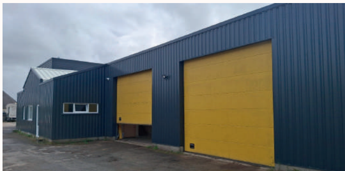
↑ Bâtiment des services techniques après rénovation
